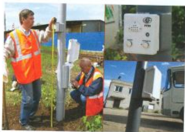
Установка оборудования ПСГО с использованием электрических изделий и коммутационной дизэлектрической стойки
